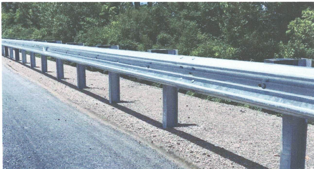
Imagem 02: Equipamento a ser utilizado, defesa metálica.
